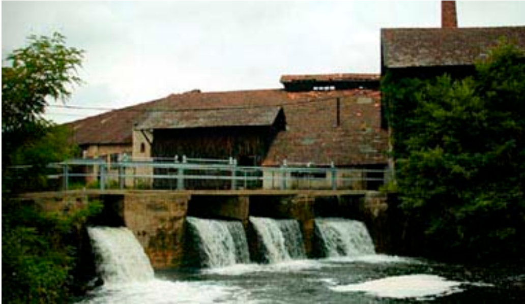
Fig. 16 : Création d'une chute à l'intérieur du bâtiment par un seuil maçonné et des pelles de décharge en position de forte retenue sur les trois passages à droite, retenue moindre à gauche..
